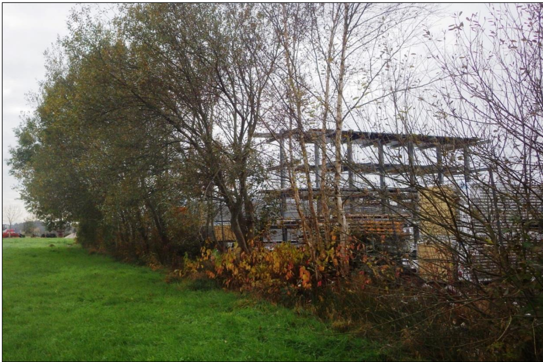
Foto 1: Baumgruppe (HBE) an der Südostseite des Firmengeländes (H & M 03.11.2017)
